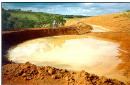
Fig. 5.6. Bacia de Captação.
